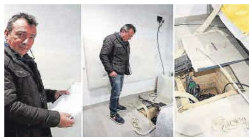
Juan Francisco Municio, vecino afectado, junto a la zona de su sótano desde donde bombea el agua.
