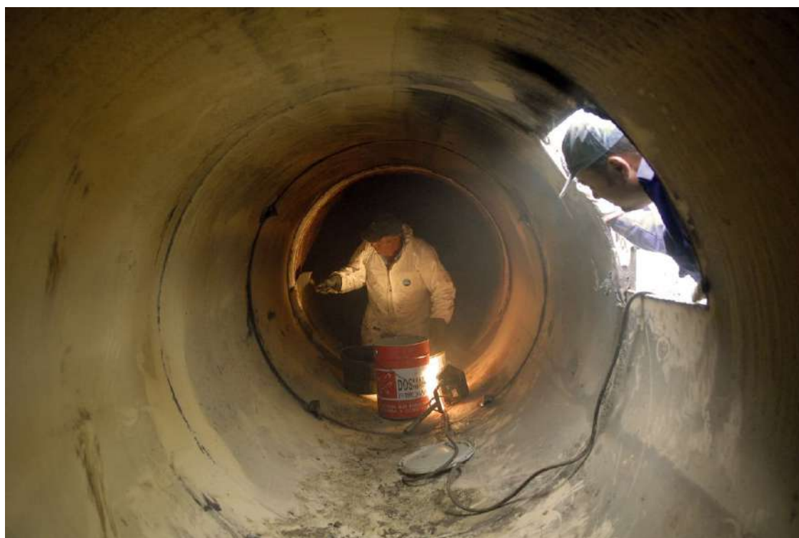
Operarios trabajan en la reparación de la rotura de una tubería de la red de agua de la ciudad de Jerez. EFE/JARO MUÑOZ JARO MUÑOZ (EFE)
