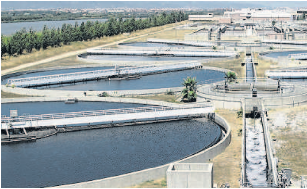
Depuradora del Baix Llobregat
